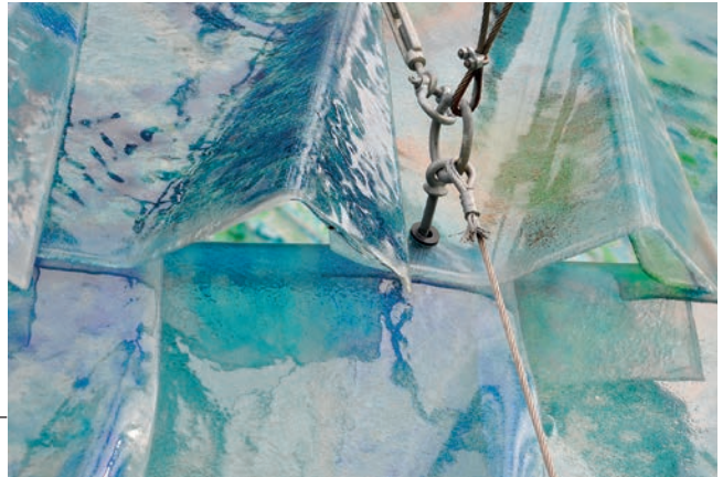
De L-vormige glazen pan haakt achter een van de stalen ringen.
