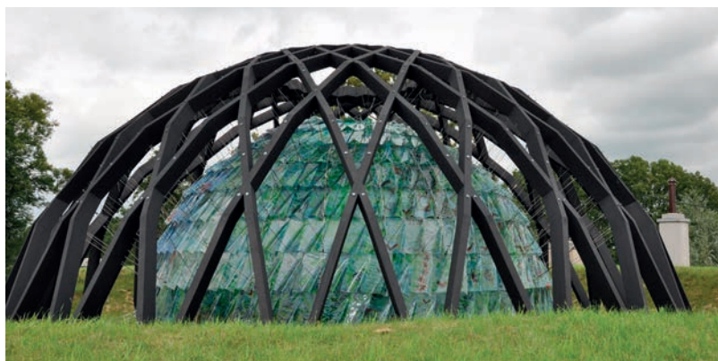
De glazen koepel is opgehangen aan een zware houten constructie, die in een betonnen ringbalk is verankerd.
