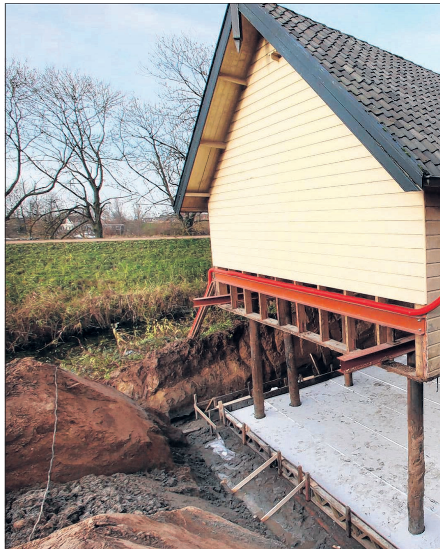
De Taveerne bij Fort Asperen staat even op palen; er wordt een nieuwe kelder aangelegd voor de keuken en toiletten.
