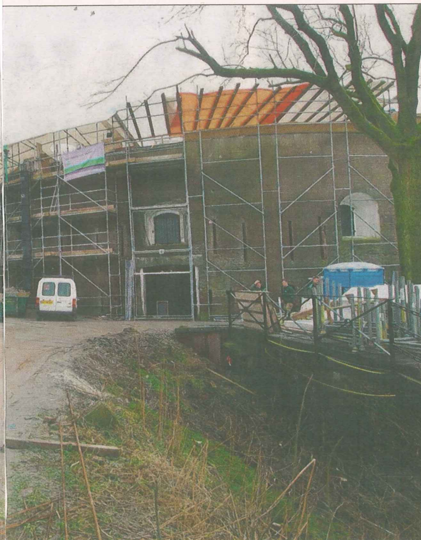
Fort Asperen gaat over een maand of twee weer open, maar voorlopig wordt er nog hard gewerkt. foto's William Hoogteyling
